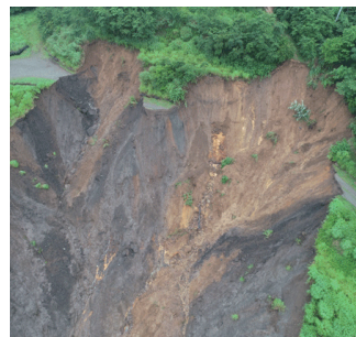
熱海市の土石流災害では、土石流の起点に存在した、開発行為に基づく盛土が崩落が原因と見られている
