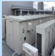
電気設備の設置場所の嵩上げ
