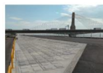
低炭素型コンクリート試行事例 （三重県桑名市長島町）
