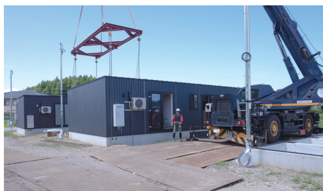
益田建設の木造モバイルユニット「WOODPOD」の設置の様子
